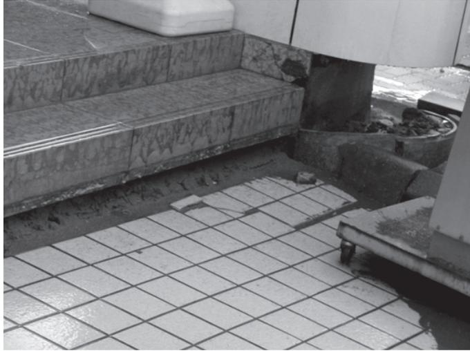
図表5 液状化で地面が陥没し、建物の基盤が剥き出しになっている（中町） 著者撮影（2011.4.24）
