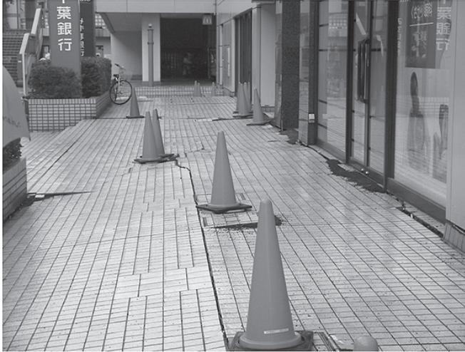
図表4 浦安駅ビルの状況（通路が液状化で波打ち、建物の地面との間に亀裂が入っている）著者撮影（2011.4.24）
